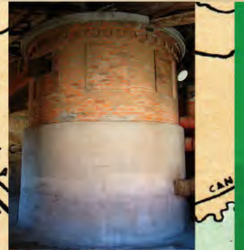
Torre piezometrica alla Gazzera per l'incrocio delle due condotte adduttrici \varnothing 800 e \varnothing 1000 mm.
