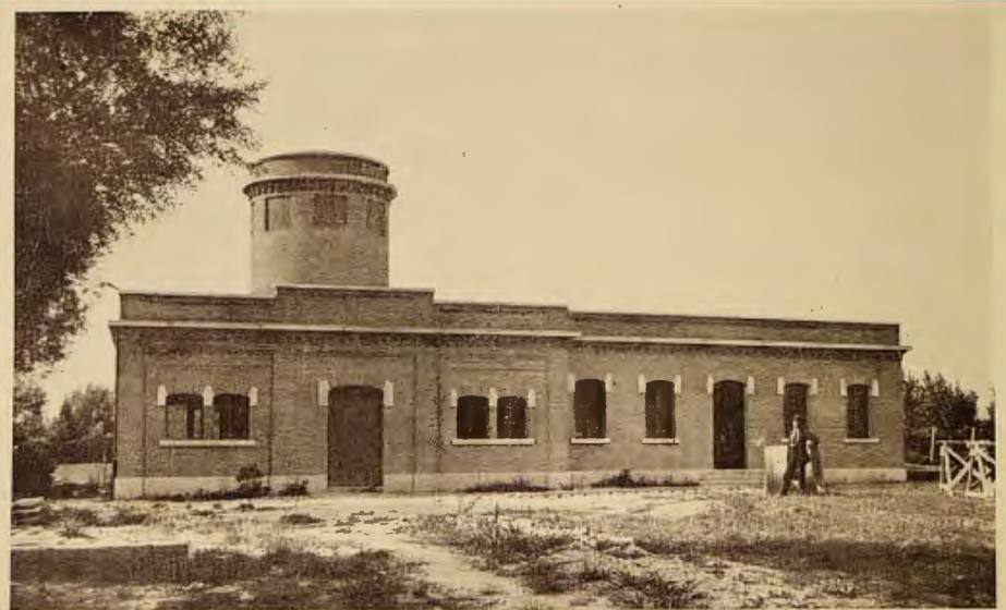
Torre piezometrica alla Gazzera per l'incrocio delle due condotte adduttrici \varnothing 800 e \varnothing 1000 mm.
